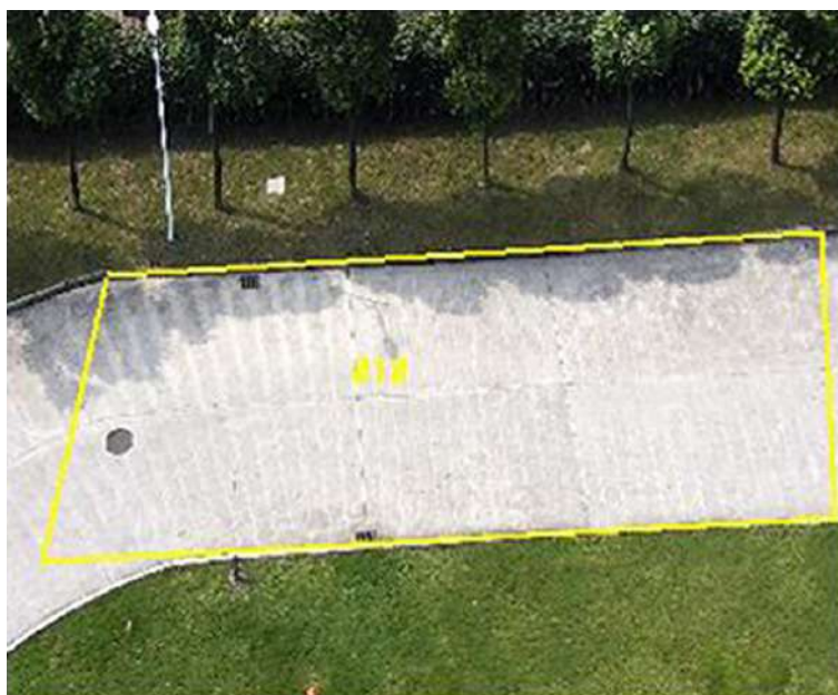
Figura 8-4 Zona de desenare
